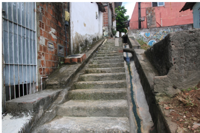
Escadaria antes da reforma.
