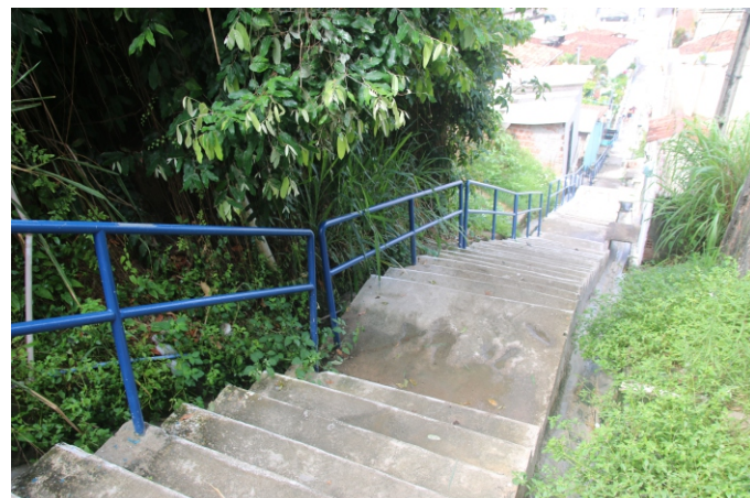
Realização da instalação de corrimões.
