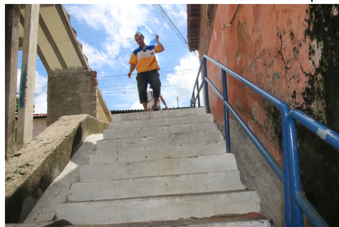
instalação de corrimões para melhor acessibilidade dos moradores.
