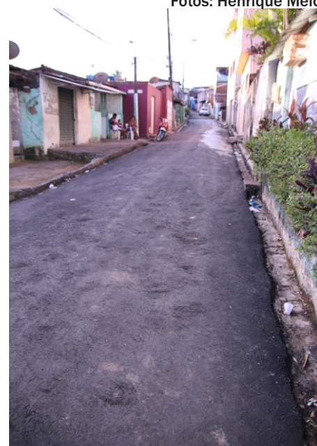
R. Alto da Saudade após realização da obra.
